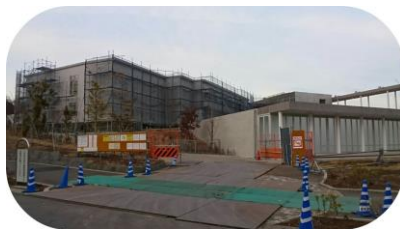
※市内各校で進む校舎増築工事
